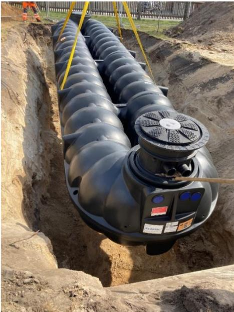
Die eingebauten Zisternen bestehen aus recyclebarem Polyethylen (PE) und sind prämiert mit dem Deutschen Preis für Rohstoffeffizienz 2014 des Bundesministeriums für Wirtschaft und Energie (BMWi) und wurden in Deutschland hergestellt. Der Einbau erfolgte von März bis April 2022 durch die STRABAG AG aus Weißwasser.
